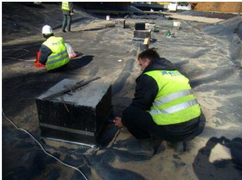
При строительстве, полотна материала соединяются между собой по средством сварки специальным аппаратом, который позволяет делать двойной шов с проверочным каналом для контроля качества соединения сжатым воздухом под давлением минимум две атмосферы. При соблюдении технологии ведения работ создается абсолютно герметичное соединение, приблизительный срок службы
