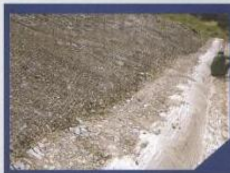
Участки газопровода р-н Красная Поляна
