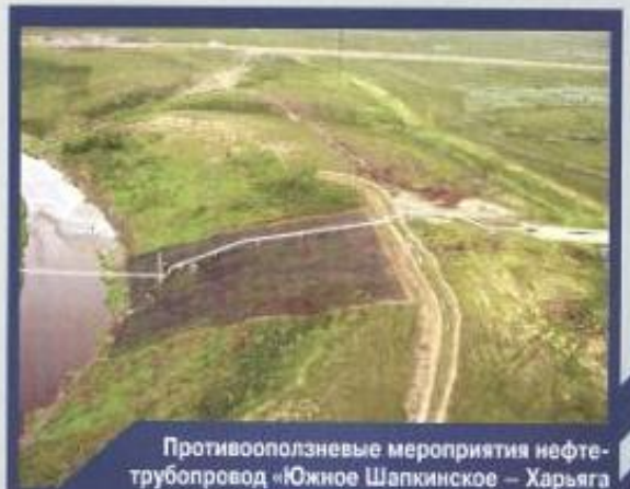
Оползневой склон. Участок магистрали М-4 «ДОН»
