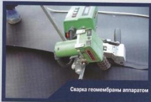
Сварка геомембраны аппаратом
