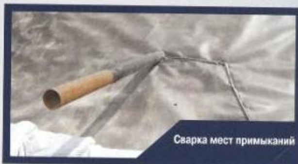
Укладка мембраны на подготовленное основание
