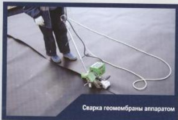
Укладка мембраны на подготовленное основание
