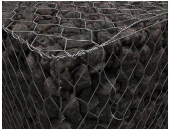
1.7 После наполнения короба плотно притянуть крышку к верхним граням и увязать проволокой. Для предотвращения сдвигов (перекосов) крышки рекомендуется предварительно притянуть крышку по периметру в углах временной провязкой.
